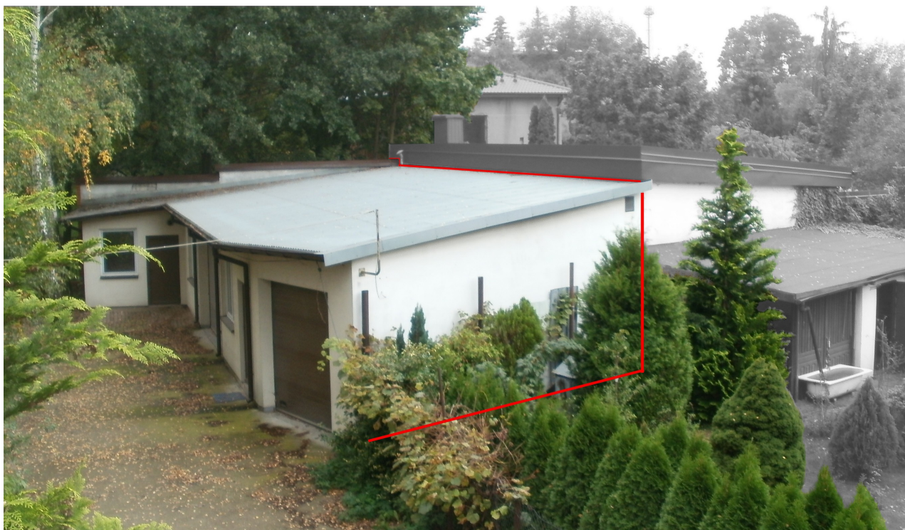
Foto. nr 1. Widok ogólny budynku garażu.
